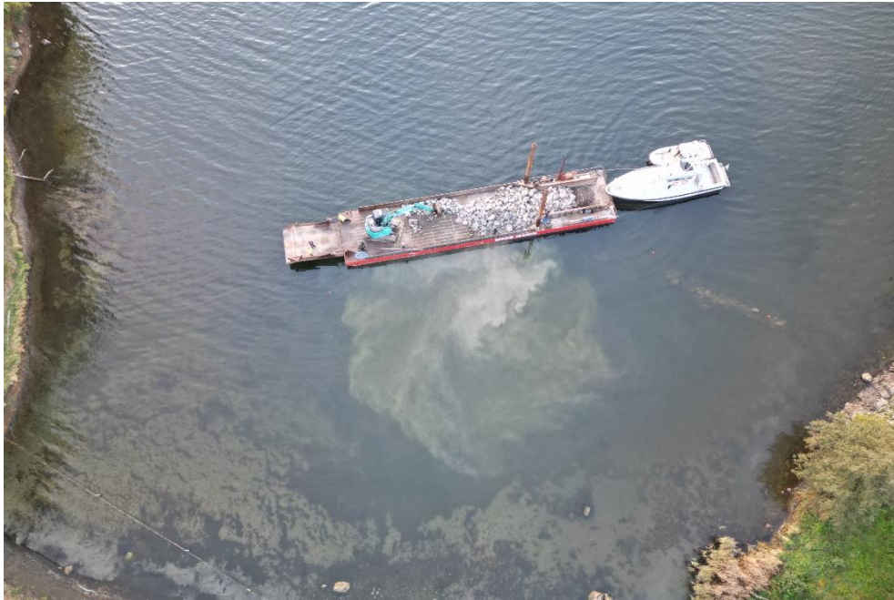
Figur 14. Stenreveln under konstruktion. Foto: Victor Sandberg.
