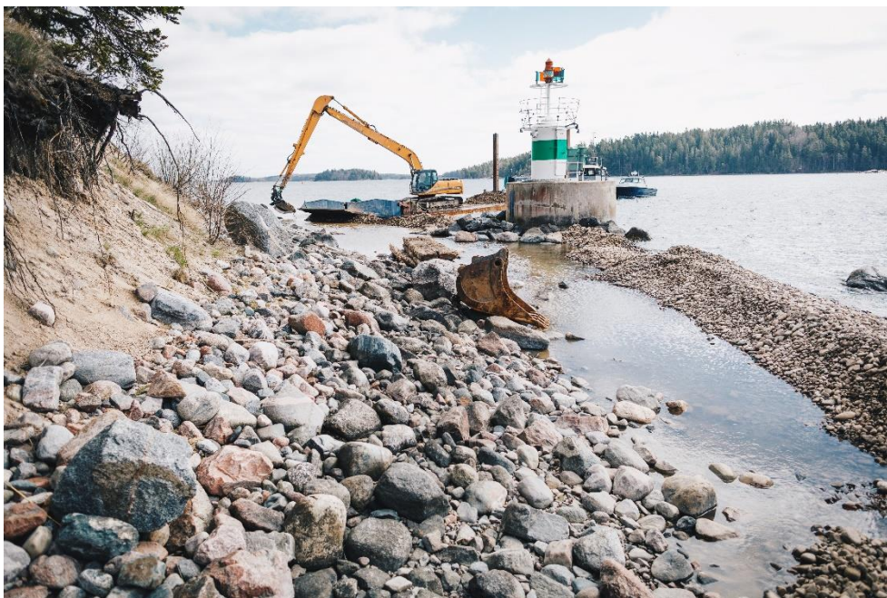
Figur 5. Tröskelvallning under byggnation vid Staboudde fyr. Foto: Ylva Bergman.
