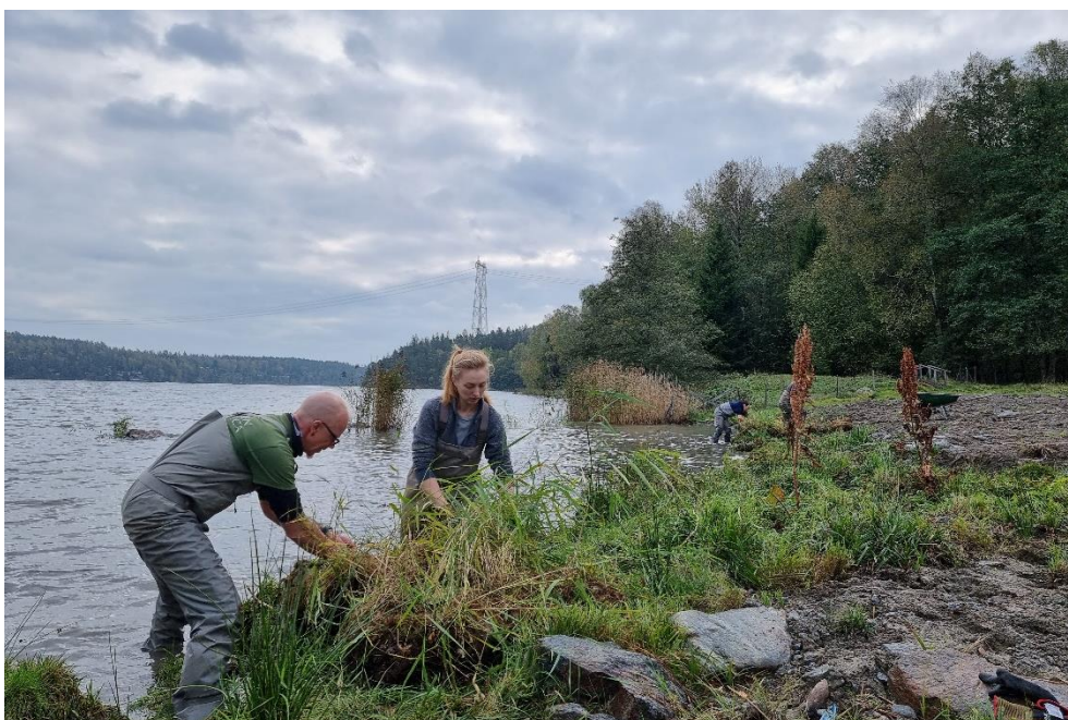
Figur 16. Vassmattorna fylldes med natursten för att hålla dem på plats på botten.
