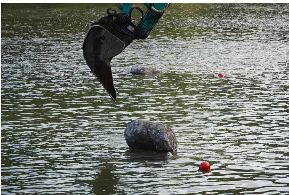
Figur 13. Stenen fördelades ut med grävmaskin. Foto: Victor Sandberg.
