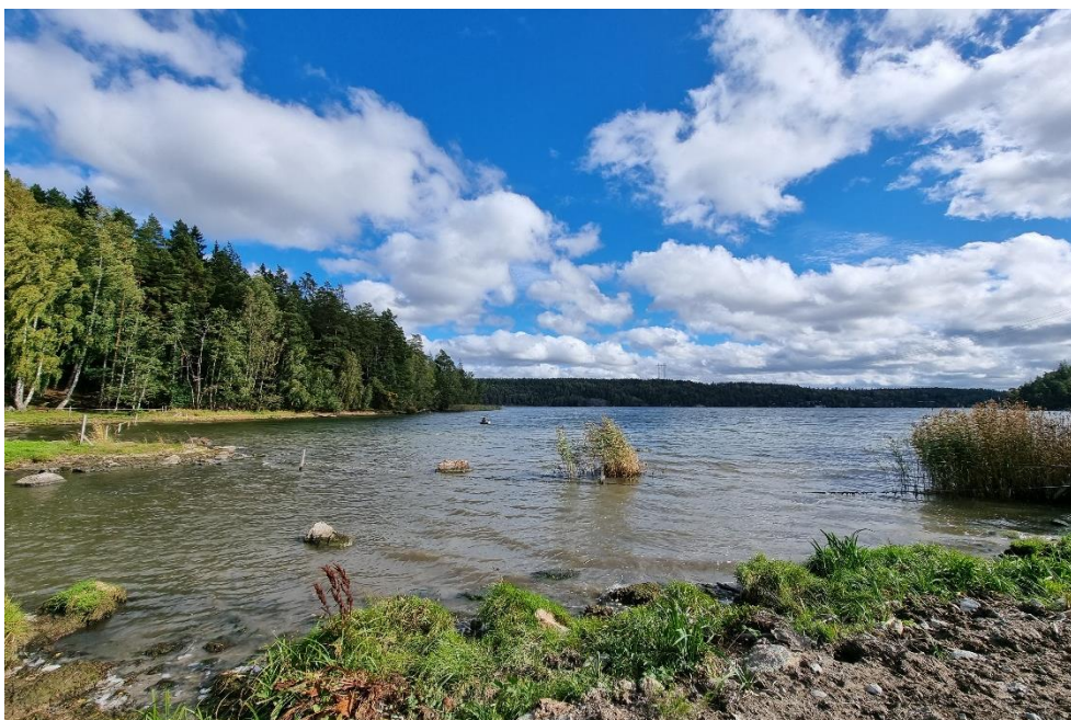
Figur 10. I Södra viken har stranden underminerats och vass finns bara kvar i enstaka ruggar i anslutning till stenstrukturer.
